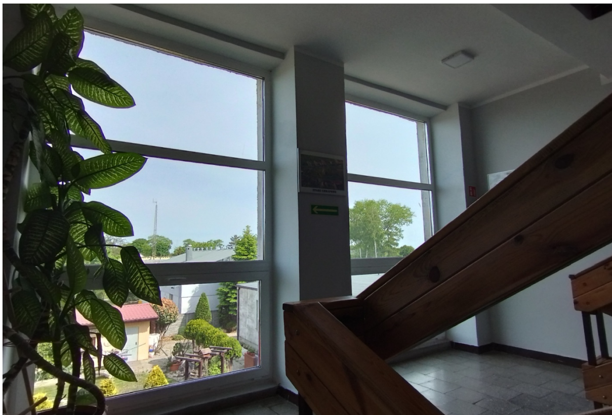
Nowa stolarka okienna w budynku Urzędu Gminy w Bielicach
