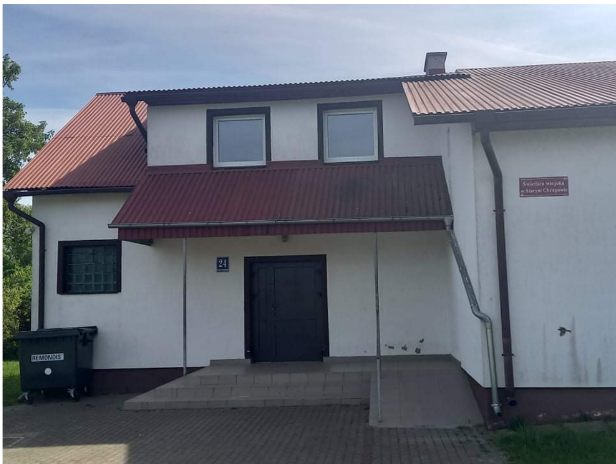
Nowa stolarka okienna w budynku świetlicy wiejskiej w Starym Chrapowie
